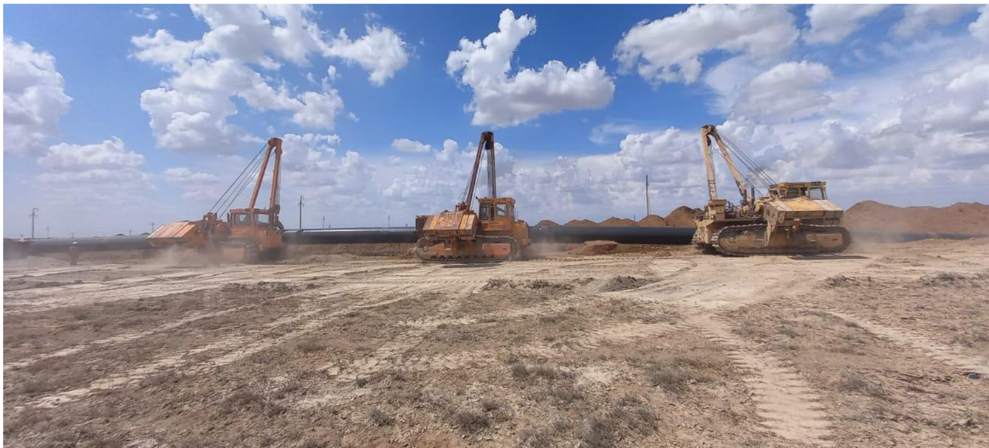
Укладка труб, ПК 1777, Комплекс-3, трасса водовода.
