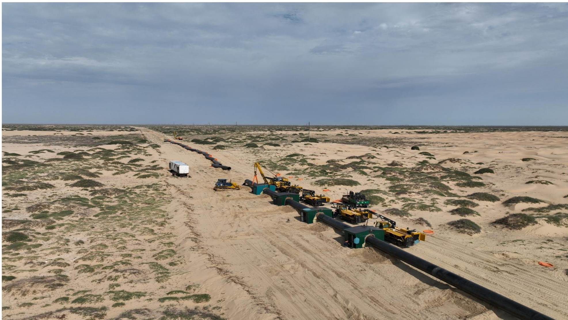
Сварочные работы, на 124км, Акколь-Исатай
