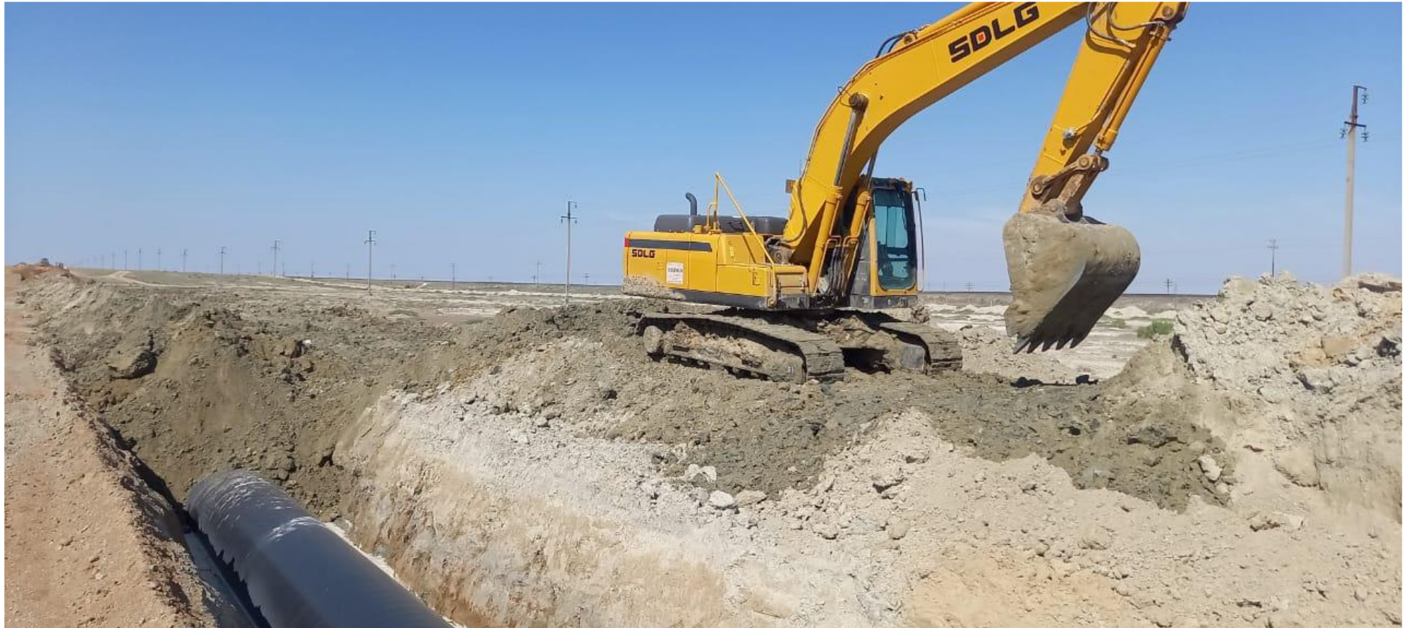
Обратная засыпка, ПК 1800, Комплекс-3, трасса водовода
