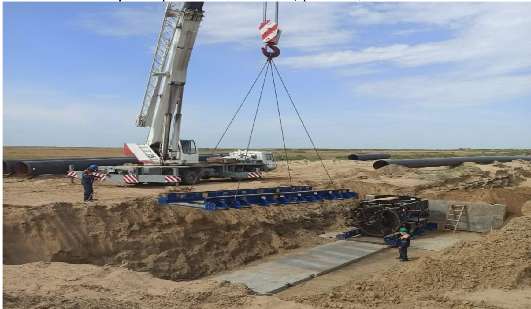
Устройство пересечения методом ГНБ, ПК 658, трасса водовода Акколь-Исатай
